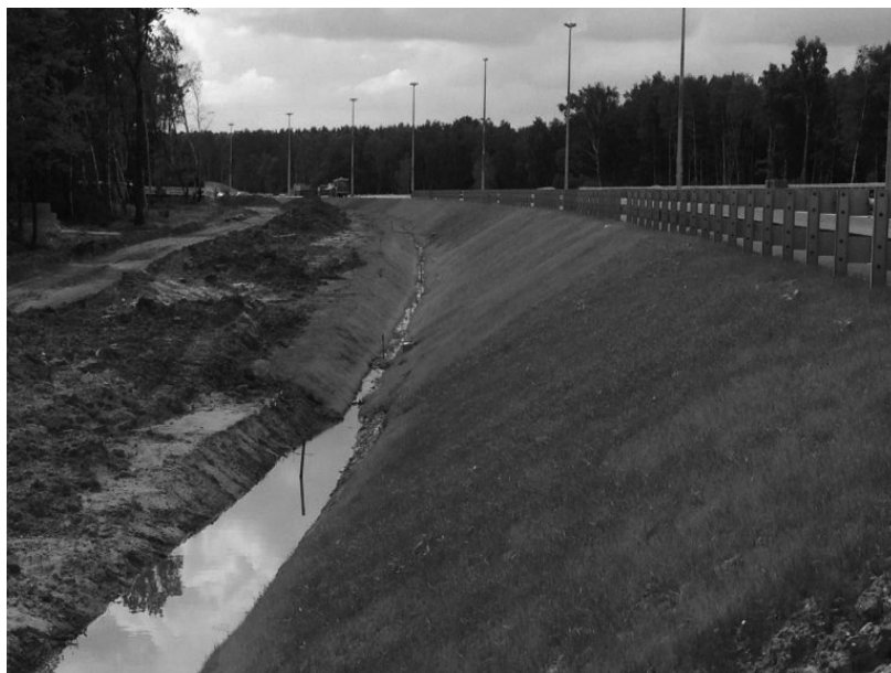
Рисунок 1 – Укрепление откосов насыпи засевом трав
