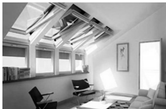
Рисунок 8 – Пример использования кровельных окон для освещения здания
